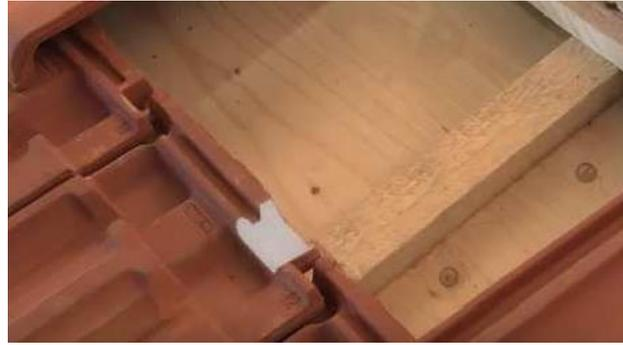
Figure 22 - Partie de tuile à retirer
