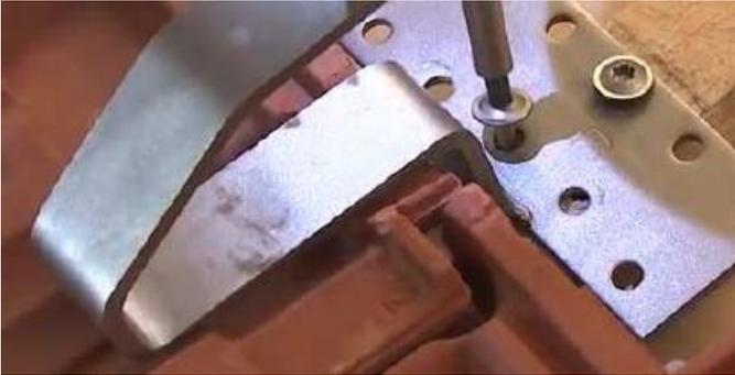
Figure 23 - Mise en position du crochet sur tuile
