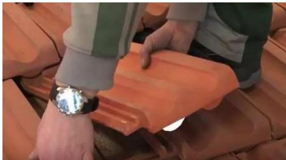
Figure 26 - Partie de tuile à retirer
