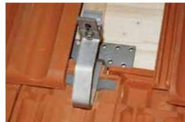
Figure 24 - Pose d'une bande d'étanchéité
